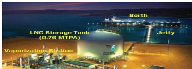
LNG Terminal – In Progress
